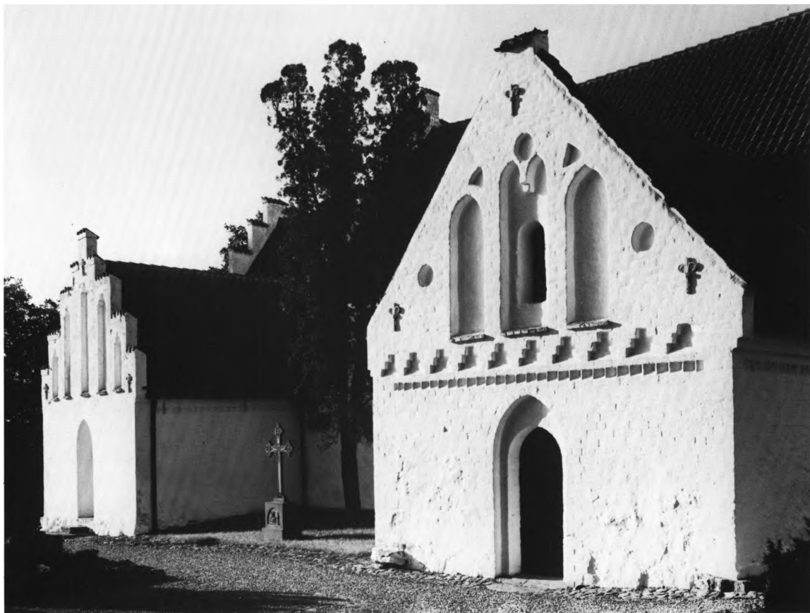
Fig. 7. Gotiske tilbygninger ved kirkens nordside: Sakristi (s. 1412) og våbenhus (s. 1410); sidstnævnte omdannet til ligkapel. HS fot. 1985. - Gothic additions at the north side of the church: sacristy and porch; the latter now transformed into mortuary.
